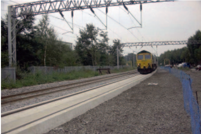
Рис. 2. Опытный участок путевой структуры типа VBEST на одной из линий железных дорог Великобритании (источник: Innotrack)
