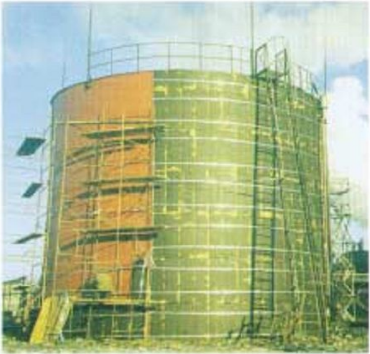
Фото 9. Теплоизоляция плитам из пенополиуретана.
