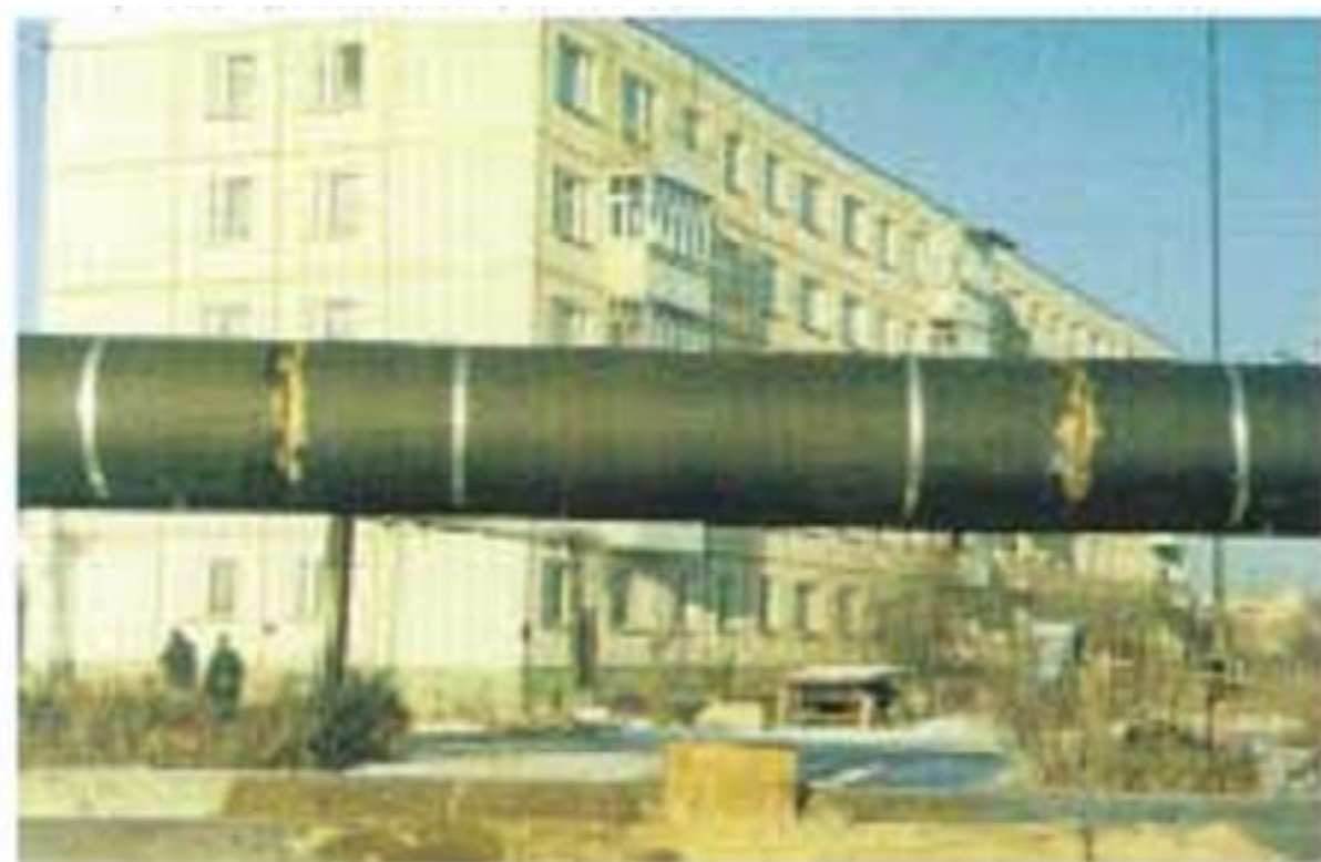
Фото 7. Тепловая изоляция скорлупами из ППУ в сборе.
