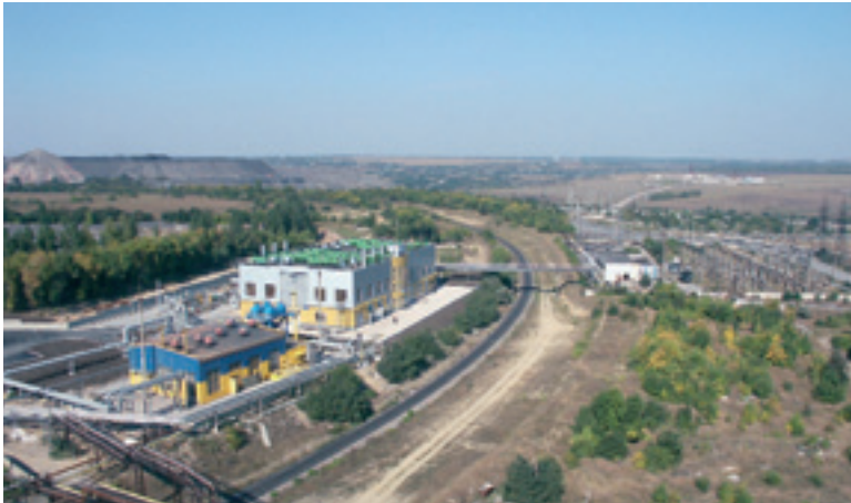
Фото 3. Общий вид ТЭС
