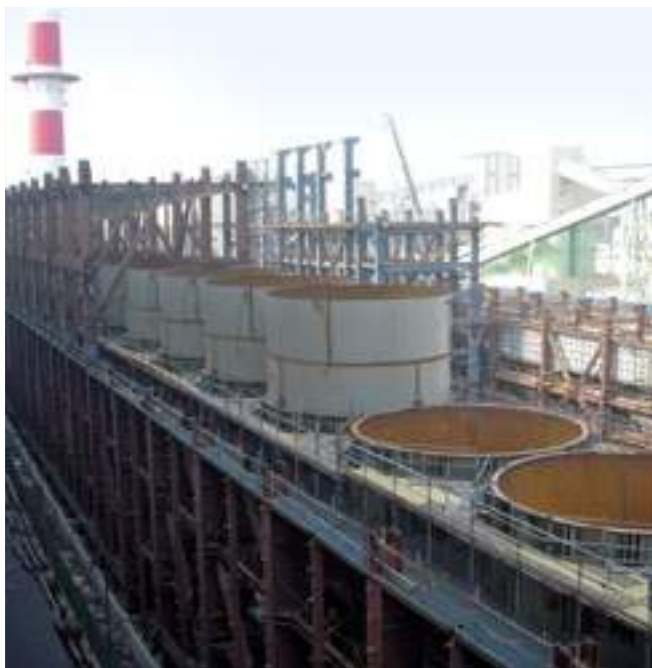
Бункеры-дозаторы на стадии строительства
