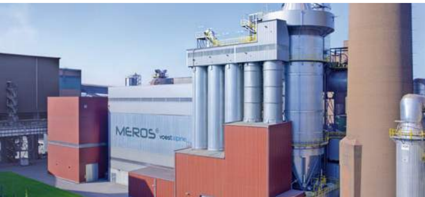
Установка SIMETAL MEROS на заводе voestalpine Stahl (Линц, Австрия)
