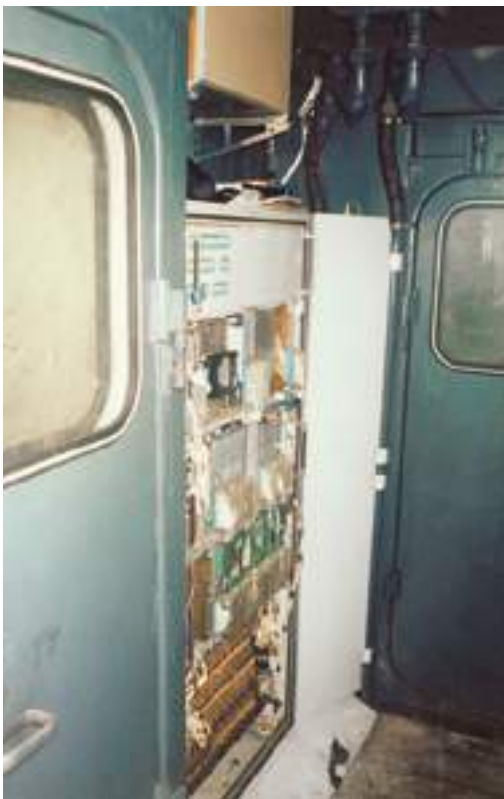
ЦБУ АПК «Пилот» в процессе эксплуатационных испытаний
