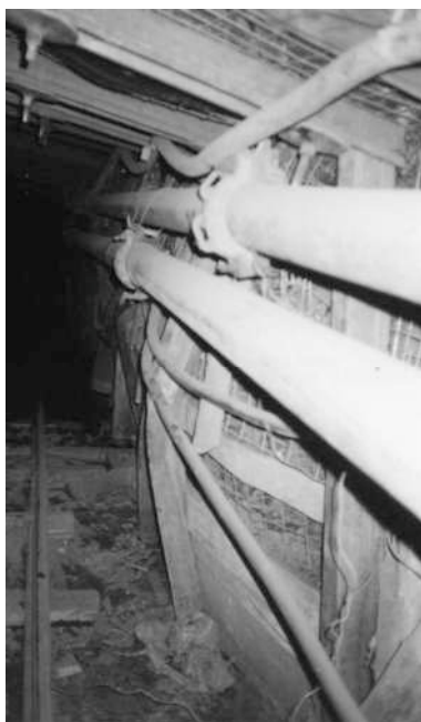
Рис. 8 – Характерные деформации боковых элементов крепи в выработке
