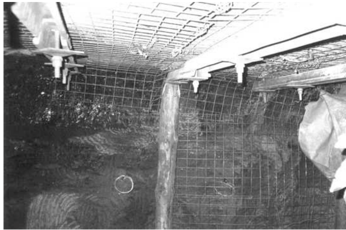
Рис. 3 – Место установки комплексной замерной станции в шестом северном конвейерном штреке пласта m_5^{1B} гор. 450 м
