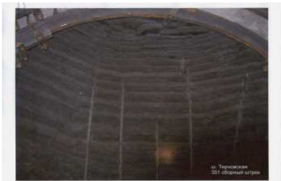
Рис.10 Состояние пород кровли в месте перекрепления 351 сборного штрека шахты Тернопольская.
