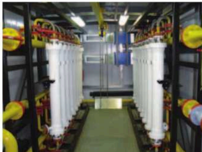
Рис. 3. Мембранная газоразделительная установка МГБ-2.5-95.0-1500 на площадке Новоукраинской КС ООО «РН-Краснодарнефтегаз»
