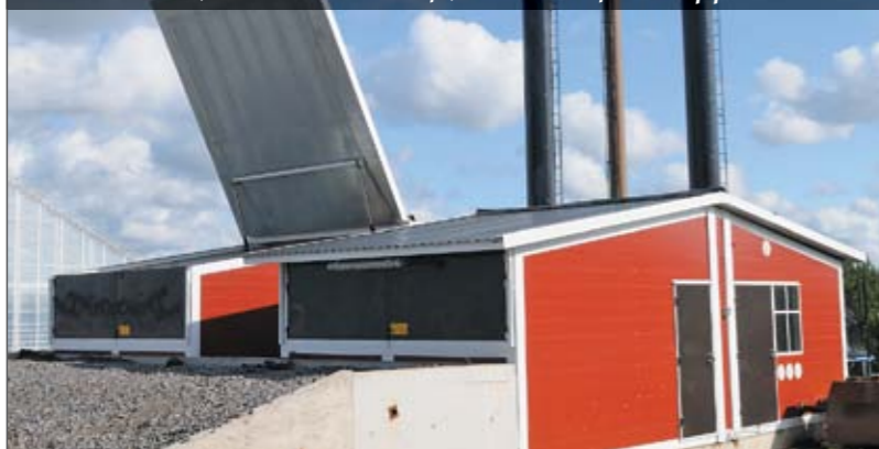
Котельная MeC 500+500 кВт производства MeгаКопе Оу, 2 бункера для топлива по 39 м 3 , отапливает теплицы, топливо – щепы и торфяные пеллеты
