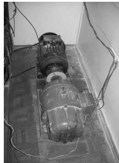
Рисунок 4 – Соединение электрических машин экспериментального стенда
