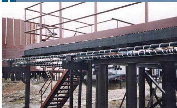
Рис.10. Система электрообогрева в стадии монтажа на месторождении
