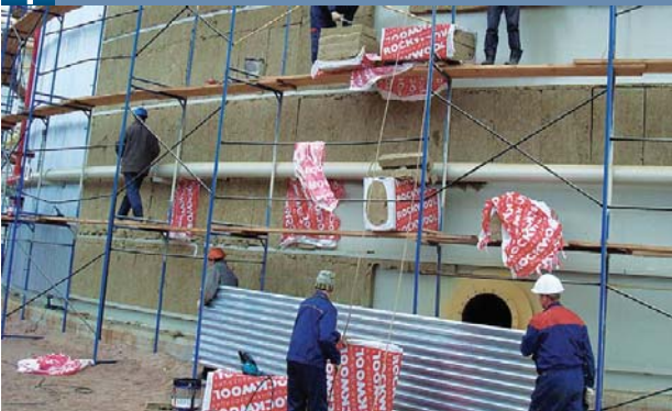
Рис.9. Система электрообогрева в стадии монтажа на месторождении
