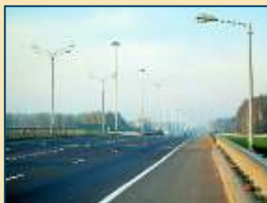
Осветительные опоры высотой 3-30 м
