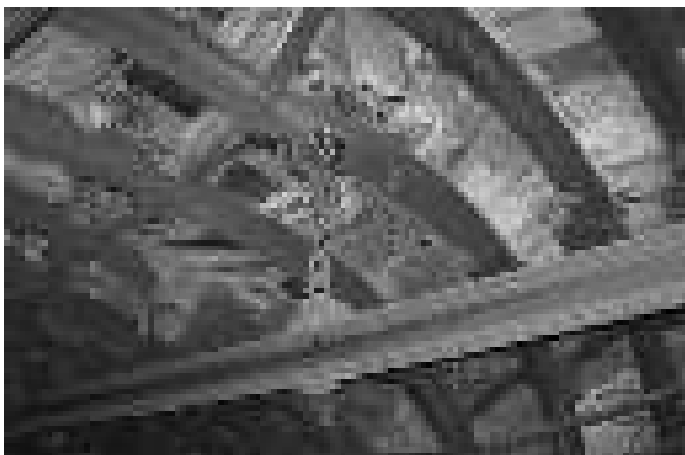
Рис. 1. Результат взаимодействия несущей рамы арочной крепи с массивом горных пород после многократного прохождения подвижного состава через стыковое соединение монорельса
