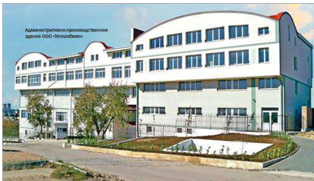
Административно-производственное здание ООО «Теплообмен»
