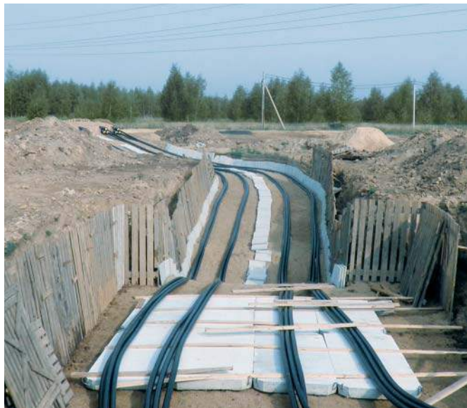
Рис. 2. Прокладка кабеля в траншее
