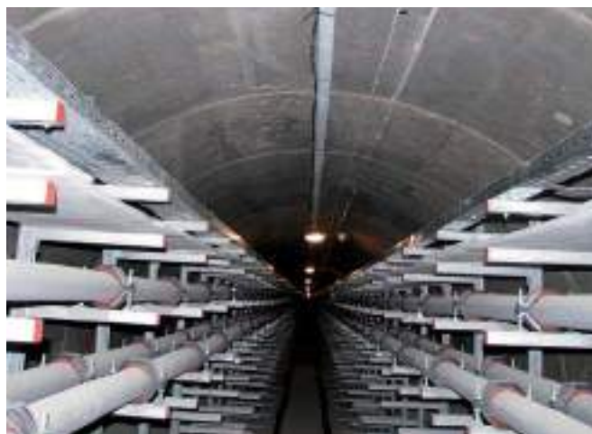
Рис. 3. Прокладка кабеля в кабельном сооружении
