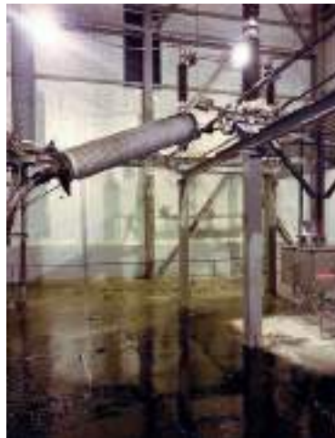
Рис. 5. Пробой концевой муфты 220 кВ
