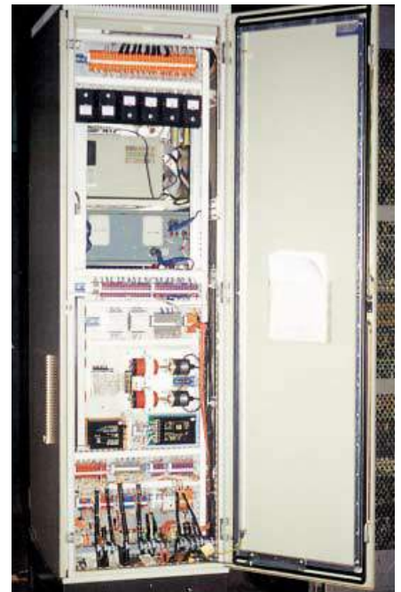
Рис. 6. Шкаф управляющей ЭВМ (вид сзади)
