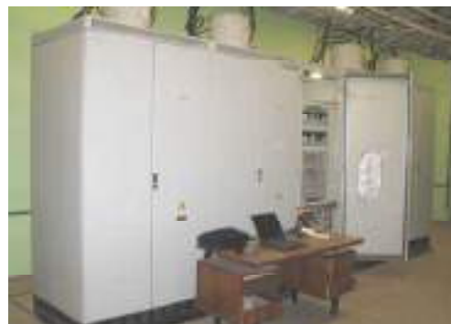
Рис.3. Тиристорный 12-пульсный преобразователь частоты ТПЧ2-6-03 рудника “Северный-Глубокий”
