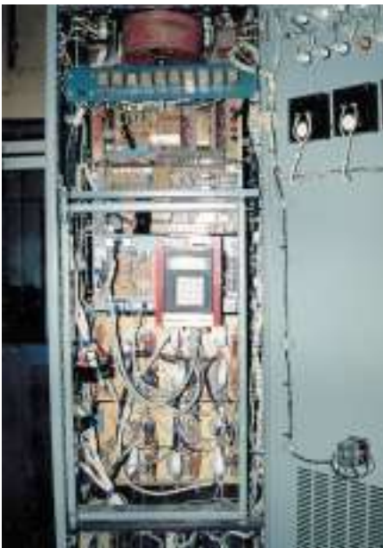
Рис. 8. Блок системы СУ-М1, встроенный в электропривод КТЭ 100/440
