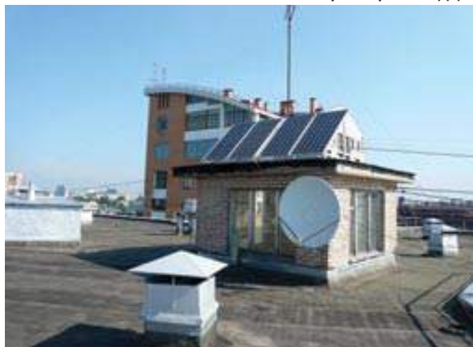
Рис.5 Солнечная электростанция Комплекс «Фотон» для подъездов жилых домов
