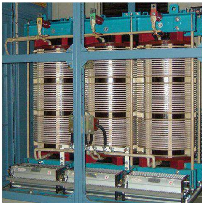
Рис. 3. Многообмоточный трансформатор
