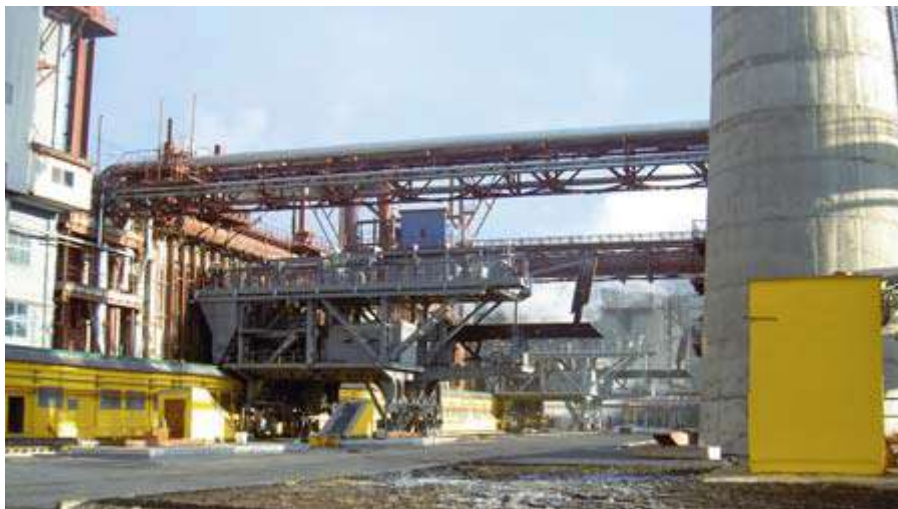
Рис. 1. ОАО «Алтай-Кокс»: коксовая батарея № 5
