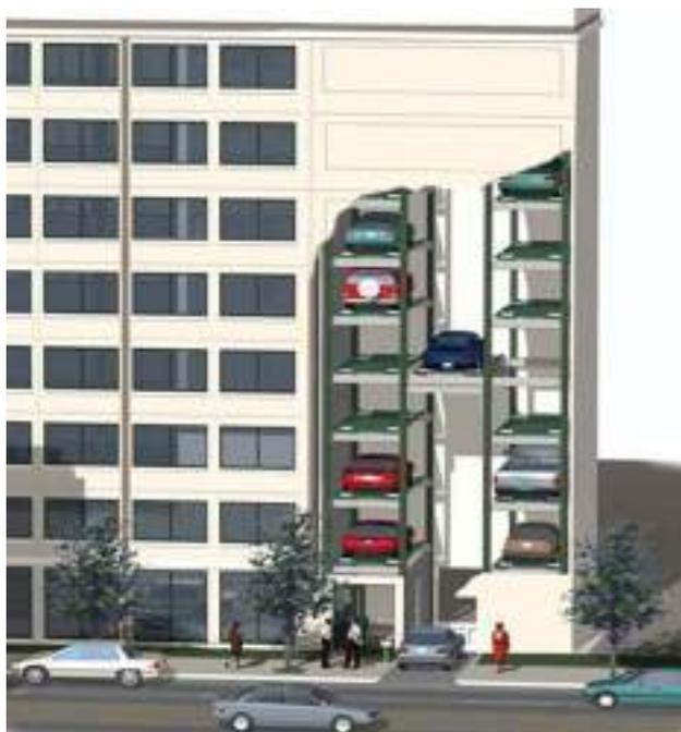
Рис. 2. Высотная МАС с двумя ММ на ярусе
