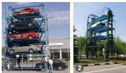
Рис. 2 – Карусельная парковка: 1 – общий вид; 2 – парковка без тента
