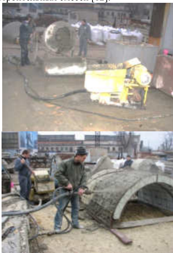
Рис. 1. Растворобетононасос на строительной площадке и процесс торкретирования
