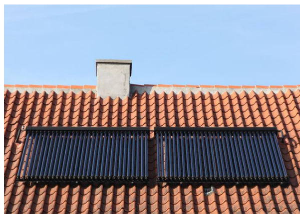
Вид активной солнечной системы с вакуумными трубчатыми коллекторами
