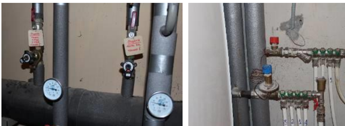
Рисунок 11- Балансировочные клапаны для систем вентиляции и кондиционирования
