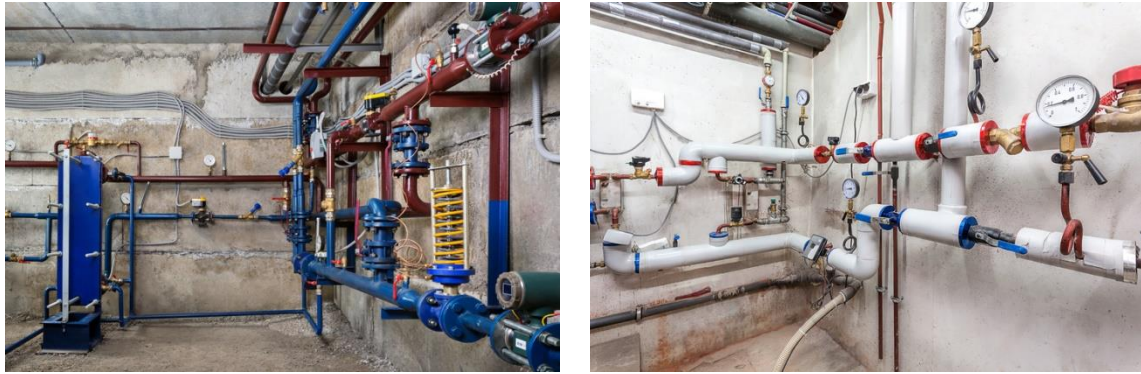
Рисунок 8 - Индивидуальный автоматизированный тепловой пункт с погодным регулированием
