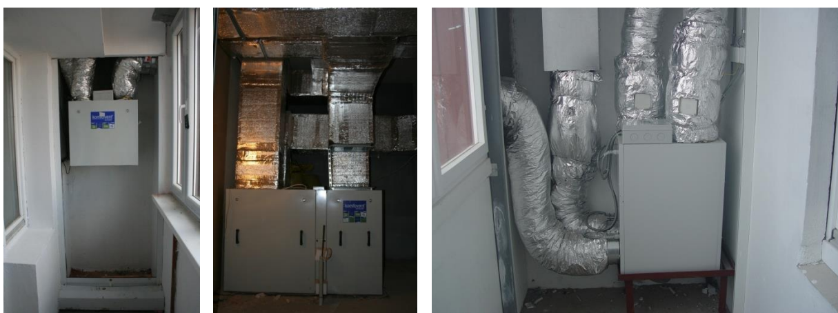
Рисунок 13 - Блок рекуперации тепла для механической приточно - вытяжной вентиляции
