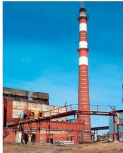
Рис. 2. Утилизационная котельная Краснокамского целлюлозно-бумажного комбината
