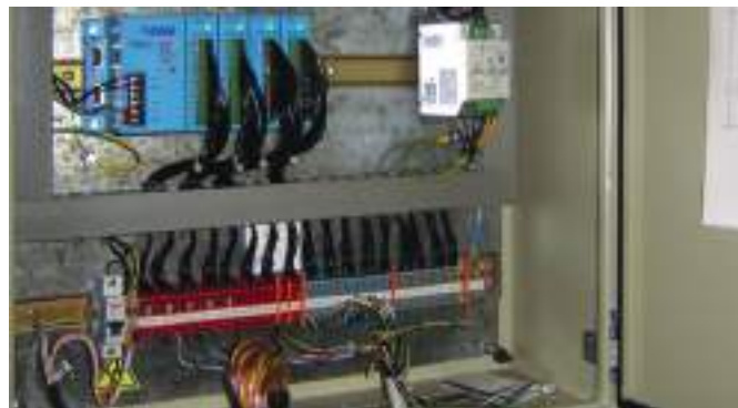
Рис. 5. Шкаф автоматики сбора данных с удалённых локальных объектов на базе контроллера ADAM-5511
