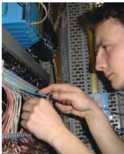
Рис. 9. С пружинными клеммами WAGO серии 280 подключение большого количества сигналов стало лёгким, быстрым и надёжным
