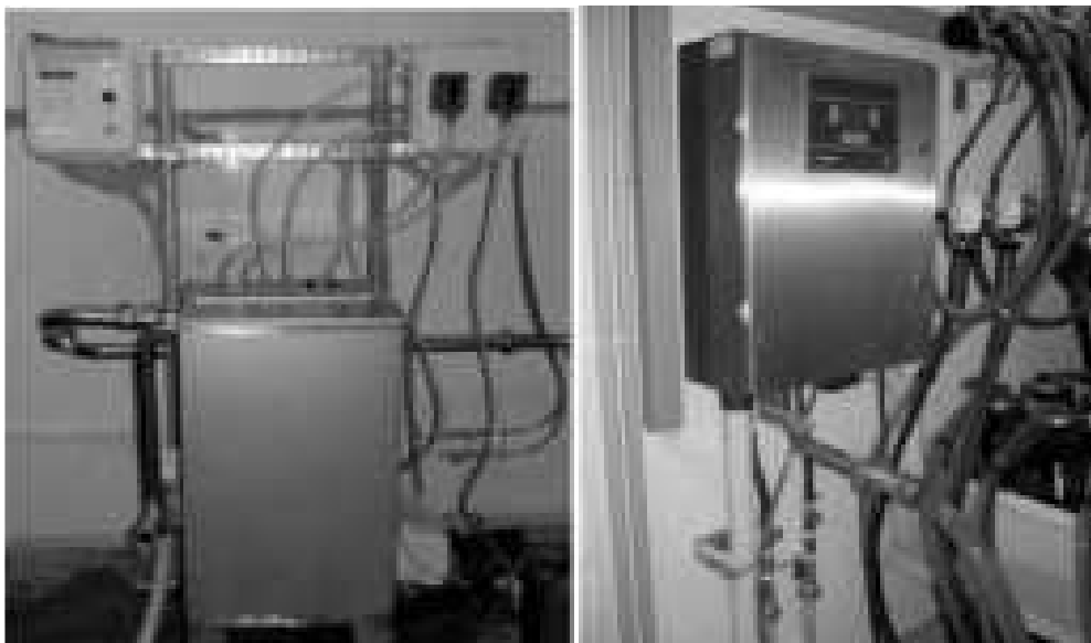
Рисунок 12. Автоматы промывки молокопроводов АПБ-1 и UNIWASH-3 (производства датской компании SaC)
