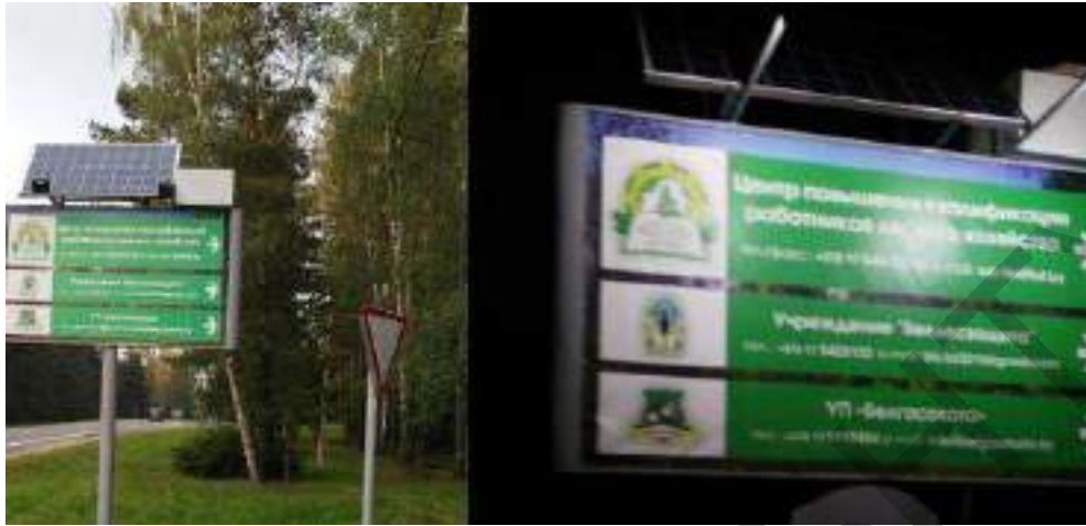
Рисунок 2. Комплект оборудования для подсветки баннера размером 2,5*1,5м. Установлен в этом году в Минском районе. В этом случае, достаточно 4 светильников мощностью 10Вт и напряжением 24В. Стоимость комплекта оборудования - от 2 100 белорусских рублей. [5].
