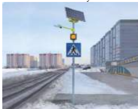
Рисунок 1. Автономное освещение пешеходного переходы
