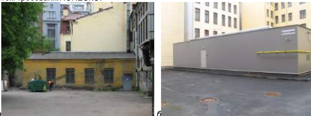
Рисунок 1. Пример модернизации котельной: а – старая, с обслуживающим персоналом; б – новая автоматизированная, без обслуживающего персонала
