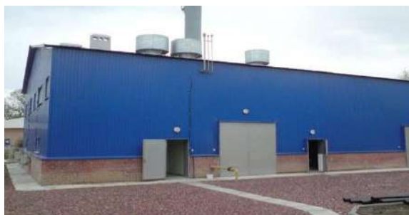
Рисунок 2 – Теплонасосная станция в г. Новошахтинске
