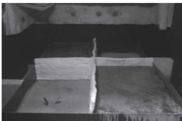
Рис. 7. Установка компенсирующей прокладки
